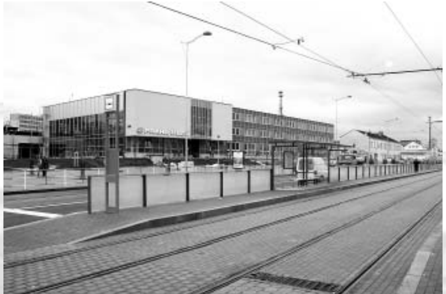
Zrekonstruovaná byla i ulice Českomoravská v Praze 9 s tramvajovou tratí. Foto © Ing. Jan Vašíček
