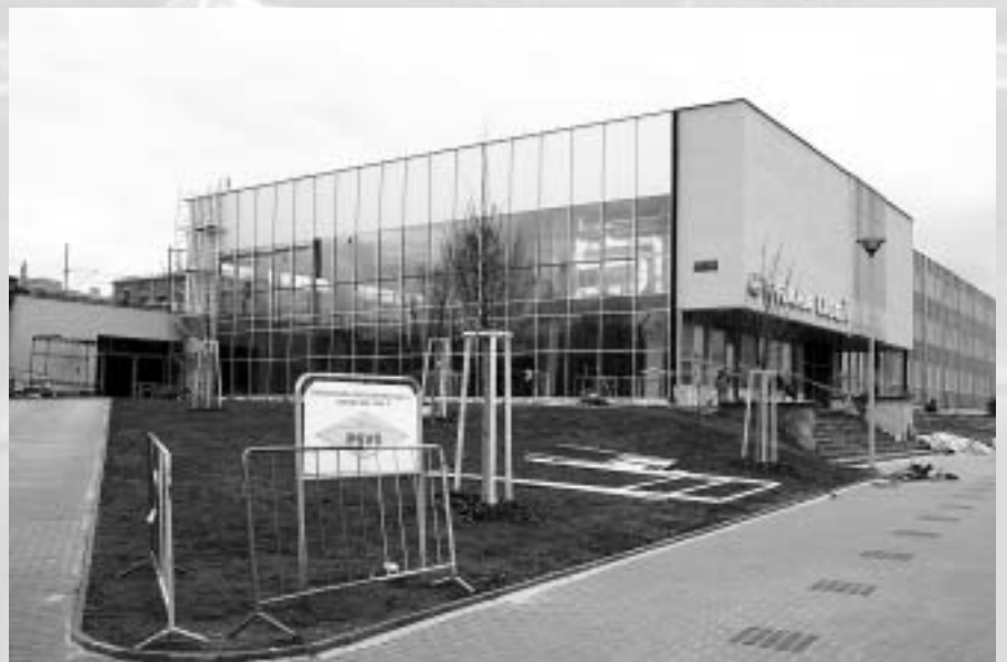
Zrekonstruovaná budova žst. Praha - Libeň. Foto © Ing. Jan Vašíček
