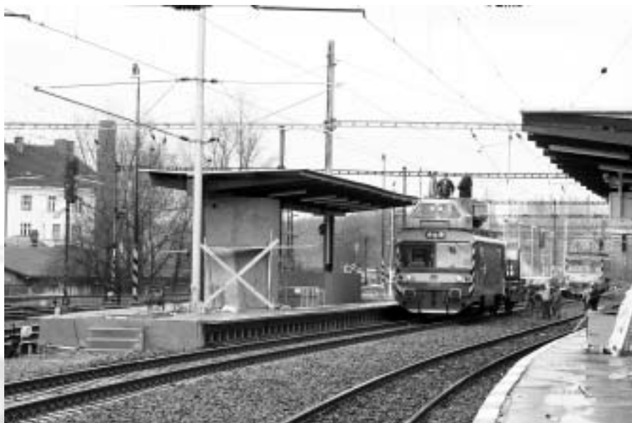
Dokončovací práce u nového nástupiště v žst. Praha - Libeň. Foto © Ing. Jan Vašíček
