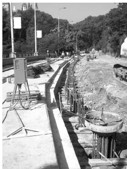
Obr. 8: Rekonstrukce opěrné stěny pod vozovkou v roce 2004 - pohled na vrtané piloty. Foto © Jan Křížek
