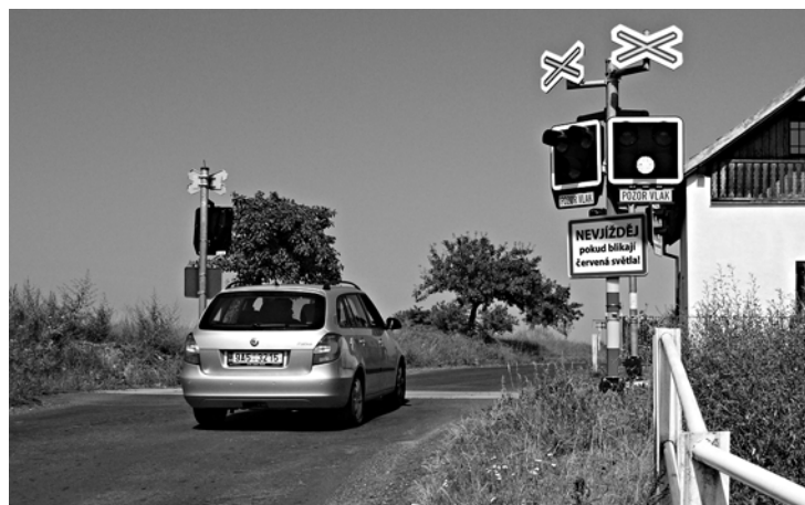
Obr. 9: Přejezdové zabezpečovací zařízení PZZ-RE/EA s příkladem zvýrazněných výstražných tabulek a ondřejských křížů na výstražníku
