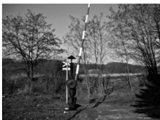
Obr. č. 2: Mechanické závoru dálkově ovládané s předzváněcím trojlístek
