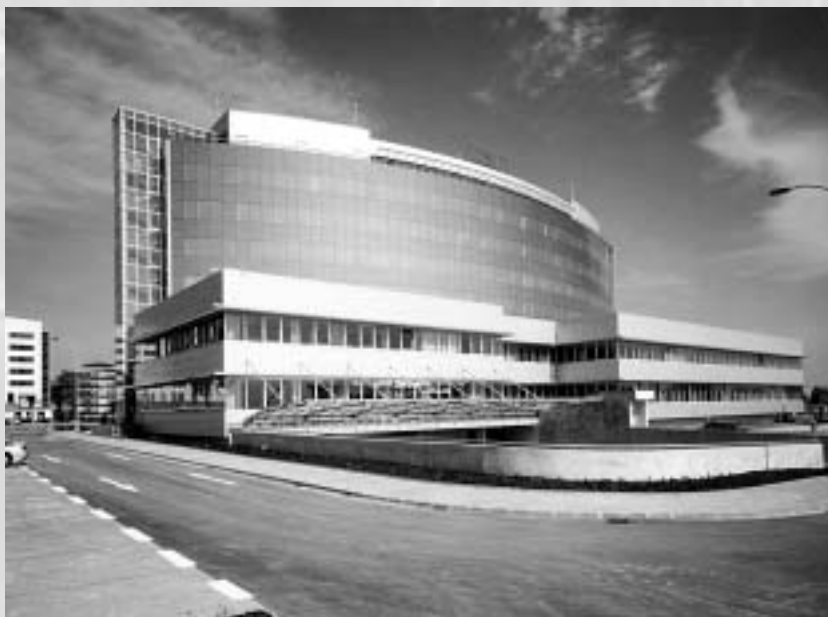
Obr. 2 Budova APC ČSA v Praze Ruzyni
