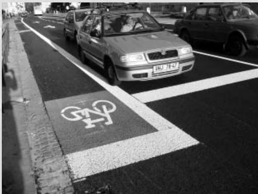
Příklad jízdního pruhu pro cyklisty v hlavním dopravním prostoru v Uherském Hradišti. Foto © autor
