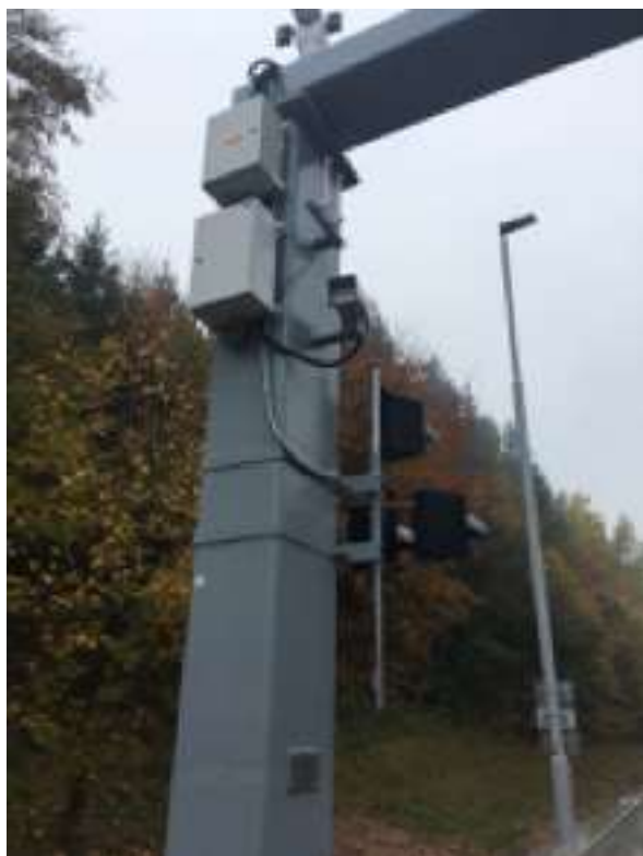
Obr. 12 Ukázka instalací RSU jednotek s integrací na řídicí systém tunelu
