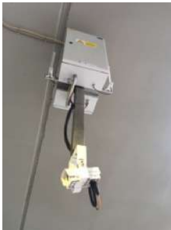
Obr. 12 Ukázka instalací RSU jednotek s integrací na řídicí systém tunelu
